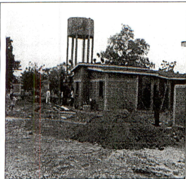
Cité étudiants 2ie en construction
