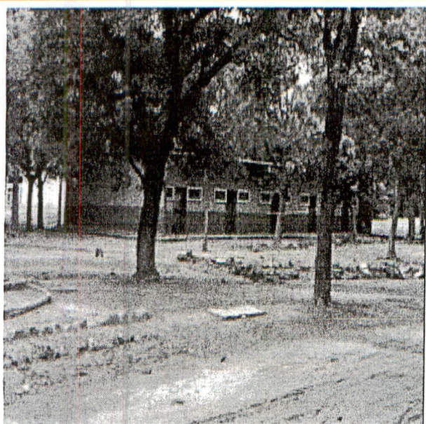
Salles de cours 2ie réaménagés
